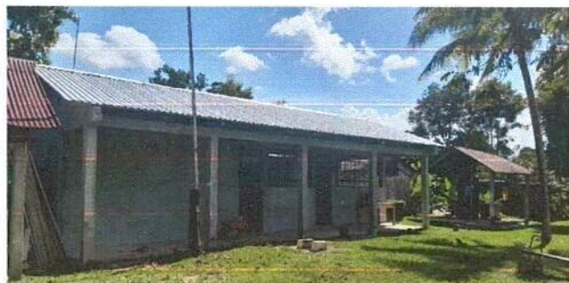
Foto 1: Sustitución de lámina de cosina para lámina troquelada aluzinc calibre 26
