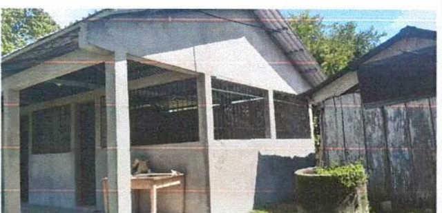
Foto 5: Sustitución de maya por balcón de metal
