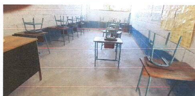
Foto 6: Sustitución de piso de torta de concreto
