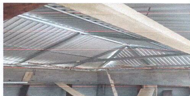
Foto 3: Sustitución de estructura de soporte de madera por metal de la cocina
