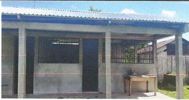
Foto 7: Repello de muro
