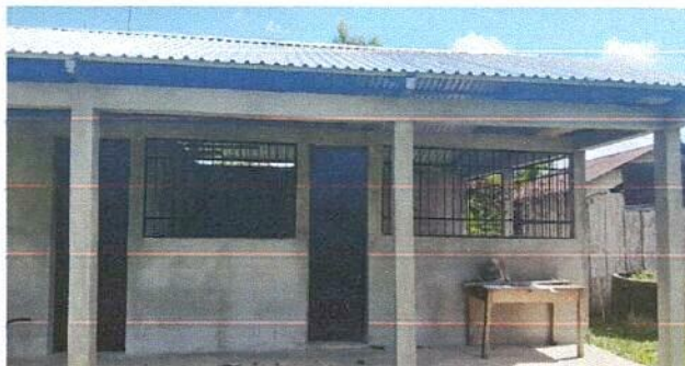
Foto 4: Sustitución de puerta de madera por metal
