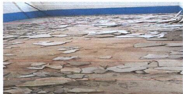
Foto 6: Sustitución de piso de torta de concreto
