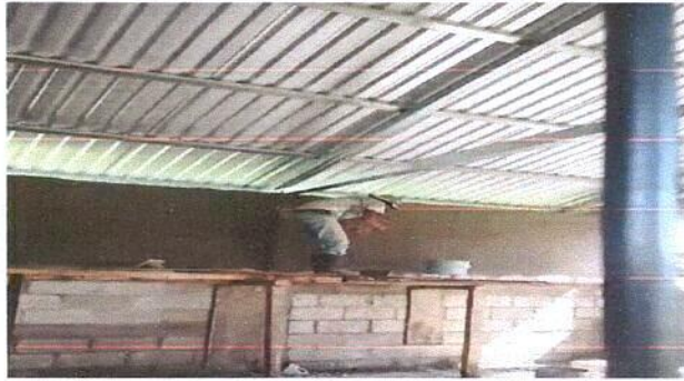
Foto 7: Repello de muro
