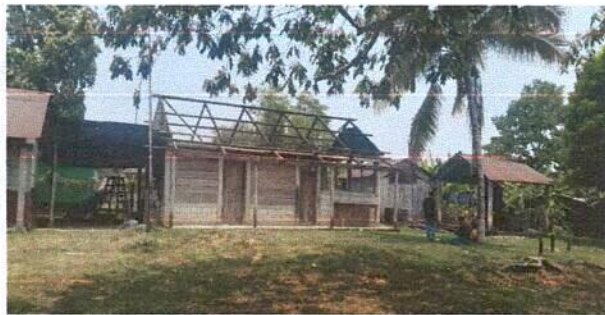
Foto 3: Sustitución de estructura de soporte de madera por metal de la cocina
