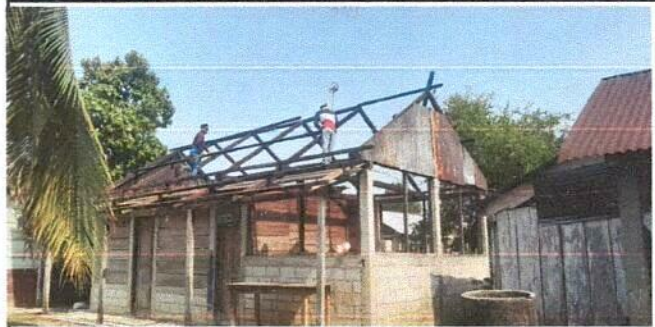
Foto 2: Sustitución de capote de lámina por lámina troquelada
