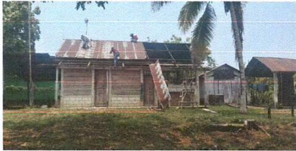
Foto 1: Sustitución de lámina de cosina para lámina troquelada aluzinc calibre 26
