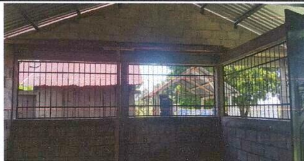
Foto 5: Sustitución de maya por balcon de metal
