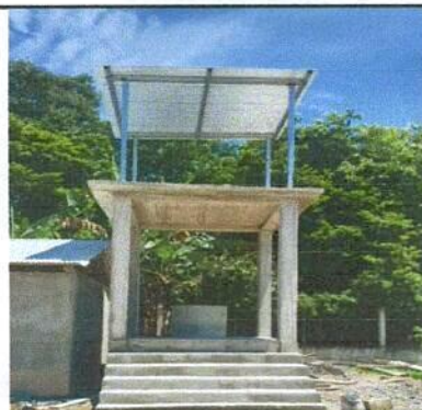
Foto 4: Pozo artesanal finalizado con sus columnos, terresa y techo.
