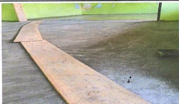
Foto 5: Piso de torta con acabado liso en las aulas.
