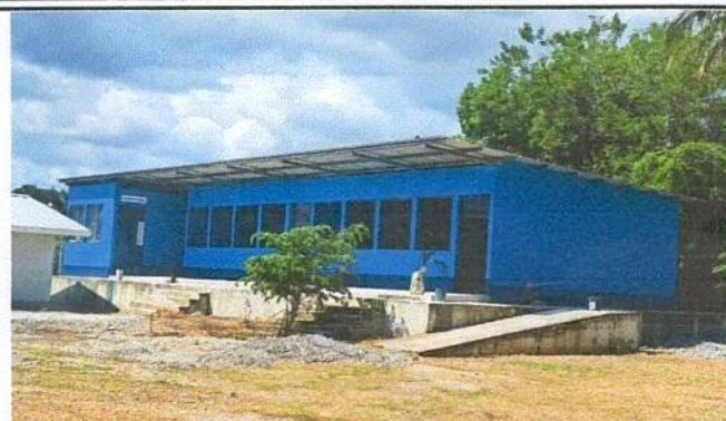
Foto 2: Establecimiento pintado en su totalidad.
