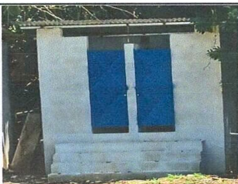
Foto 3: Láminas culminada con sus respectivas puertas.
