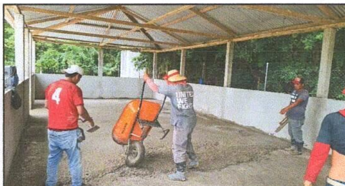
Foto 3: Aplicación de piso de torta con acabado liso en salón educativo.
