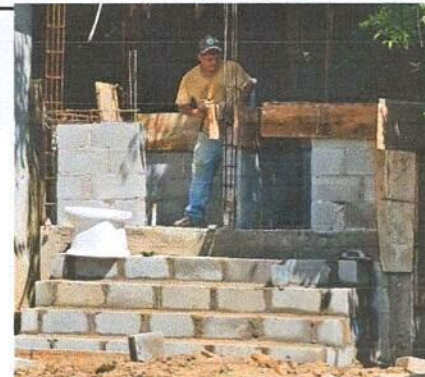
Foto 4: Ampliación de letrinas aboneras.
