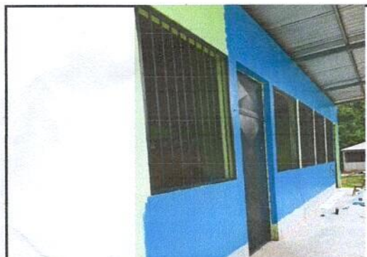
Foto 5: Aplicación de pintura en el centro educativo.
