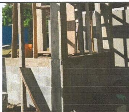
Foto 2: Brocal de pozo en construcción.
