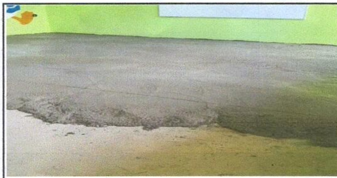
Foto 6: a)- Aplicación de piso de torta con acabado liso en aulas.
