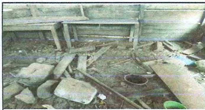
Foto 5: Sustrucción de piso de torta de concreto
