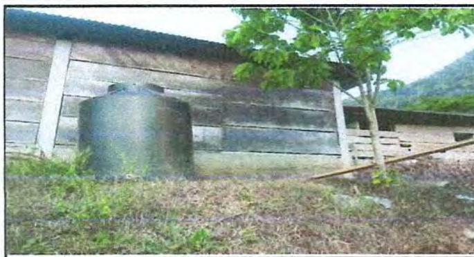
Foto 6: Sustrucción de deposito de agua 1000 lt
