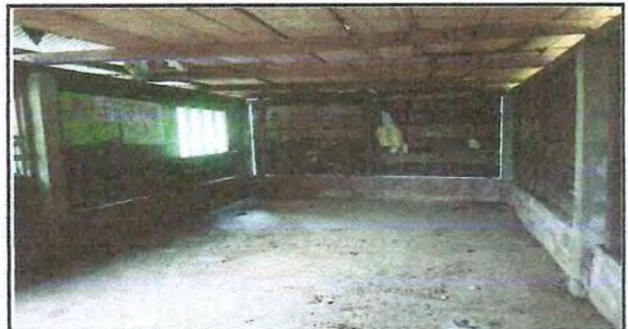
Foto 12. Sustitucion de piso de torta de concreto
