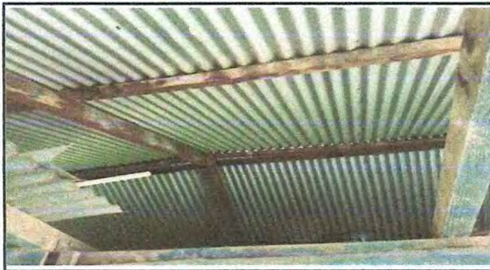
Foto 9. Sustitucion de estructura de soporte de madera, por metal
