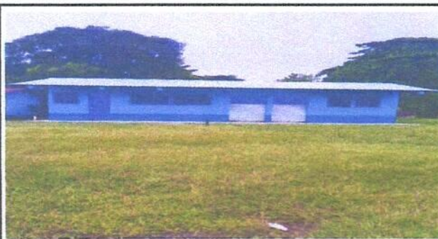
Foto 6: Vista frontal de la escuela.
