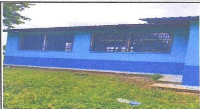
Foto1: Área de ventanas que se colocaran los balcones.
