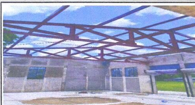
Foto 2: Techado general por laminas troqueladas y parte de estructuras metalicas.
