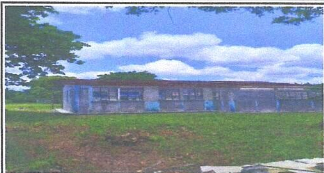
Foto 1: Area de ventanas que se colocaran los balcones.
