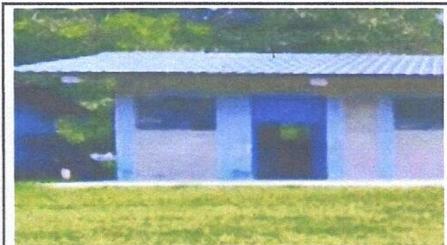
Foto 4: Puertas a cambiar.
