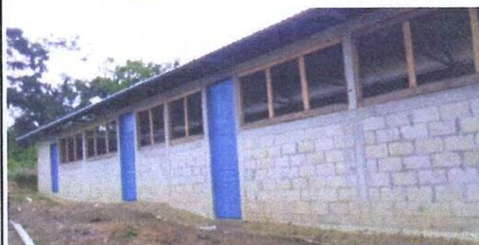
Foto 4: SUSTITUCION DE PUERTA DE MADERA POR METAL
