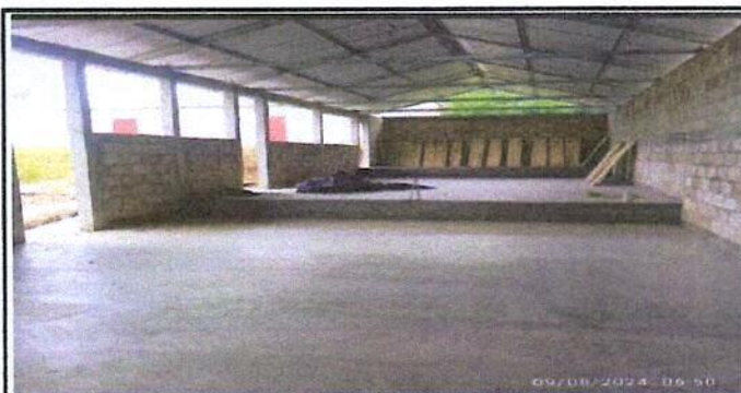
Foto 5: PISO DE TORTA DE CONCRETO
