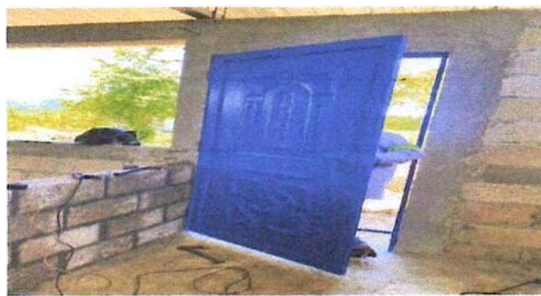
Foto 4: SUSTITUCION DE PUERTA DEM MADERA, POR METAL.
