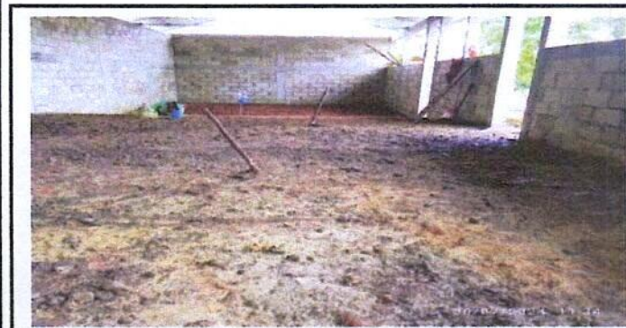
Foto 5: PISO DE TORTA DE CONCRETO
