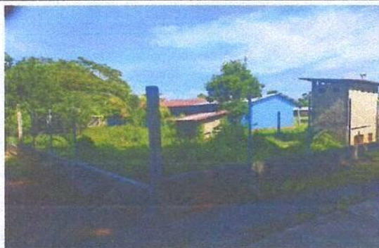
Foto 2: Esquina de muro perimetral finalizado.
