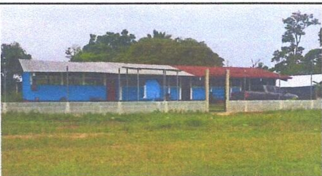
Foto 3: muro perimetral frontal de la escuela finalizado.
