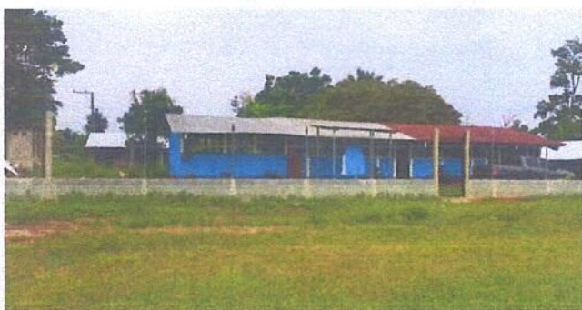
Foto 1: Vista general de muro perimetral finalizado.
