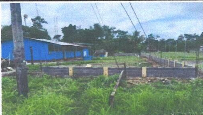
Foto 3: Avance del muro perimetral.
