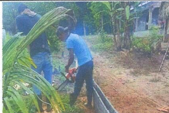
Foto 2: Colocación de block en circulación perimetral de escuela.
