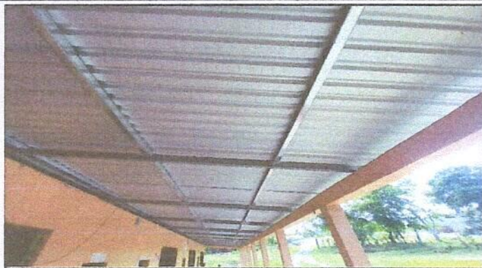
Foto1: Colocación de estructura de techo de metal
