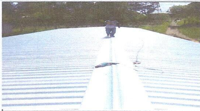
Foto 2: Colocación de lámina
