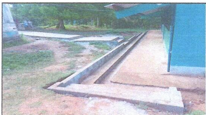
Foto 4: Reparacion de cuneta y banqueta.
