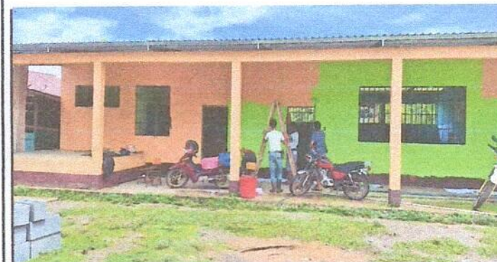
Foto 5: Pintura de muros exteriores
