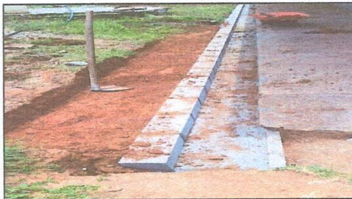
Foto 4: Reparación de cuneta y banqueta.
