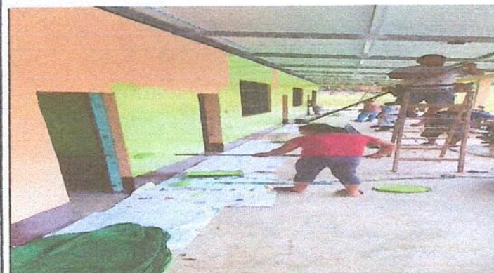
Foto 3: Sustitución del cableado eléctrico e instalación de ducto.
