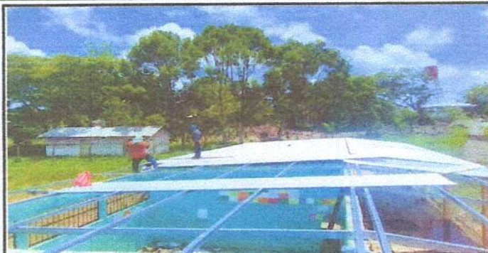
Foto 2: Colocación de lamina
