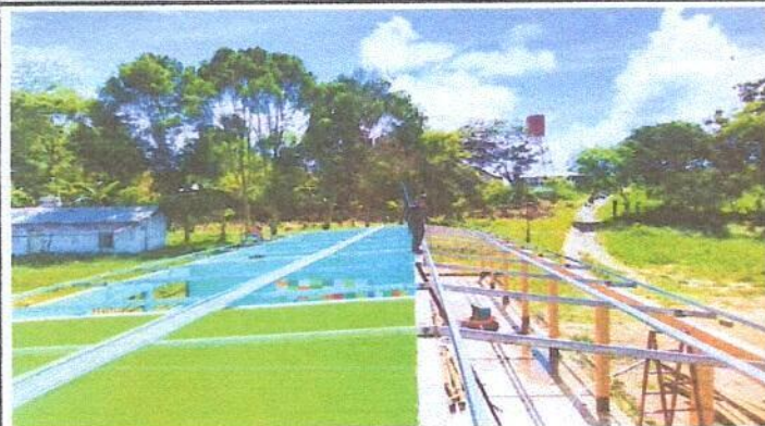
Foto 1: Colocación de estructura de techo de metal
