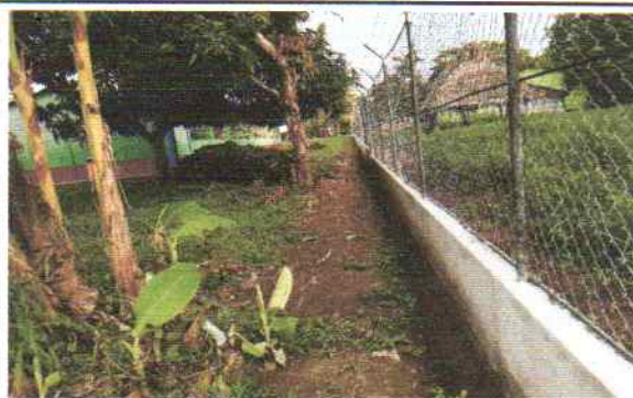
Foto 4: LA PARTE DE ATRÁS DEL EDIFICIO ESCOLAR.
