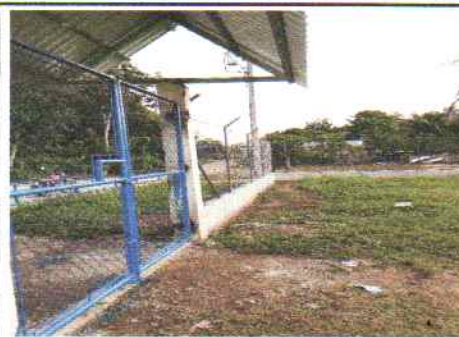
Foto 2: PORTON ENTRADA PRINCIPAL.
