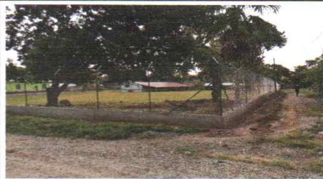
Foto 3: ASI QUEDÓ LA ESQUINA, EL ENMALLADO Y REPELLO DEL MURO.
