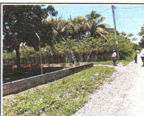
Foto4: MÓDULO 1. INSTALACION DEL ALAMBRE ESPIGADO AL ANCLAJE DEL PUNTA DE LA MALLA.
