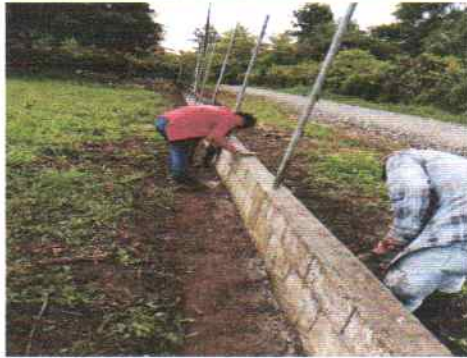
Foto 1: MODULO 2. REMOZAMIENTO LIMPIEZA DE PARED MURO PERIMETRAL .
