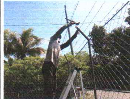
Foto 6: INSTALACION DE TAPONERAS PVC, PARA TUBOS PARALES DE MALLA.
