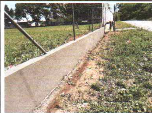
Foto 4: REPELLO DEL MURO PERIMETRAL
