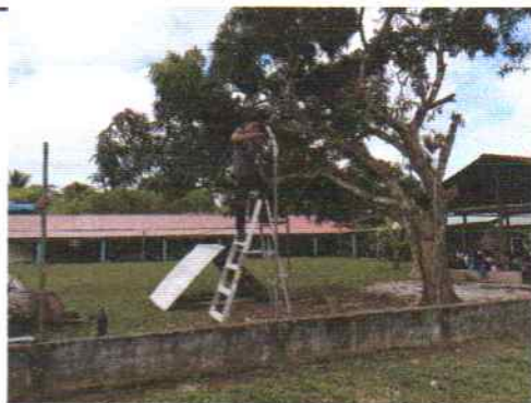
Foto3: MÓDULO 1. INSTALACION DEL ANCLAJE AL PUNTA DE LA MALLA.
