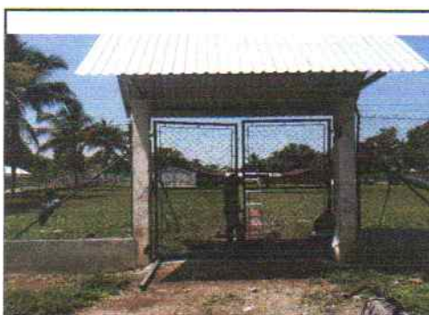
Foto6: MÓDULO 1. INSTALACION DEL PORTON.
