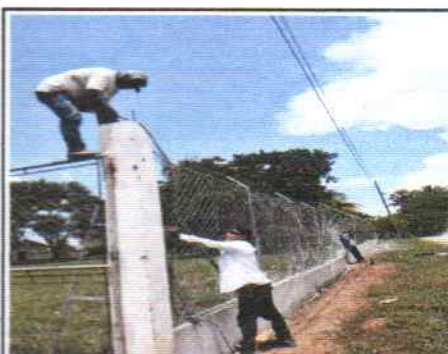
Foto5: MÓDULO 1. INSTALACION DE LA MALLA METALICA.
