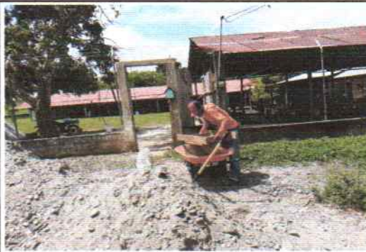
Foto 3: MODULO 2. REMOZAMIENTO REPELLO DE PARED.
