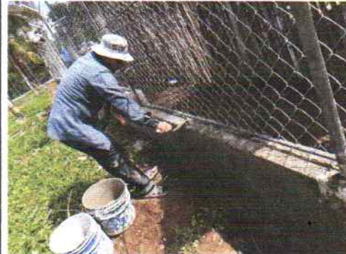
Foto 2: MODULO 2 REPELLO DEL MURO PERIMETRAL.
