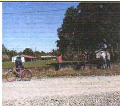
Foto 1: MODULO 1 DESMONTAJE DE MALLA METALICA EN MAL ESTADO.
