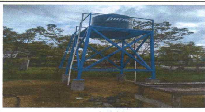
Foto 6: OBRA TERMINADA EN SU TOTALIDAD
