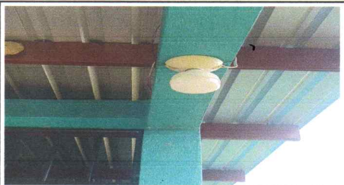
Foto 5: COLOCACION DE FOCOS EN LA ESCUELA
