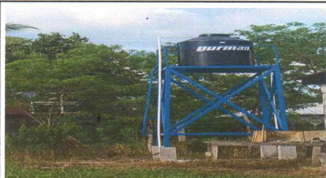
Foto 4: COLOCADA DEPOSITO DE AGUA SOBRE LA BASE DE METAL
