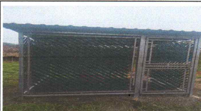
Foto 2: TERMINADA LA CASA PARA RESGUARDAR EL POZO DE LAS INCLEMENCIAS DEL TIEMPO.
