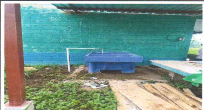
Foto 3: TERMINADA LA LLEVADA DEL AGUA HACIA LA COCINA
