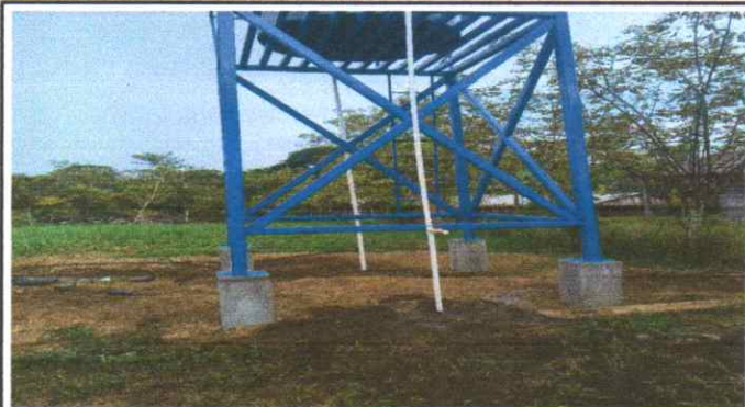
Foto 1: TERMINADO LA BASE DE METAL.
