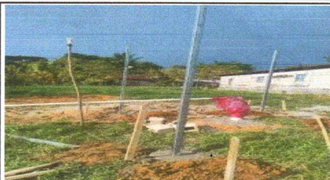
Foto 2: CONSTRUCCION DE LA CASA PARA EL POZO
