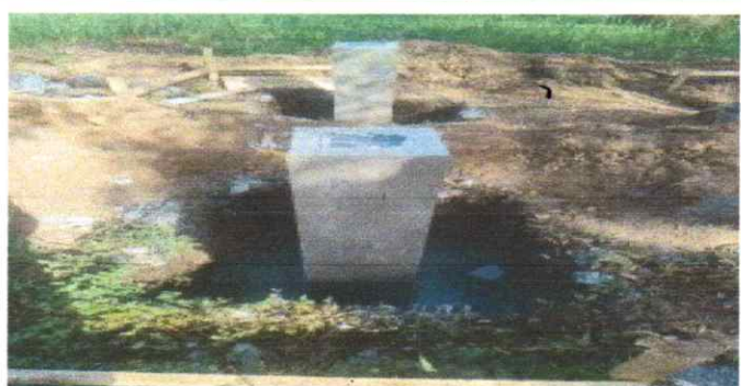
Foto 5: ELABORACION DE BASES DE CONCRETO
