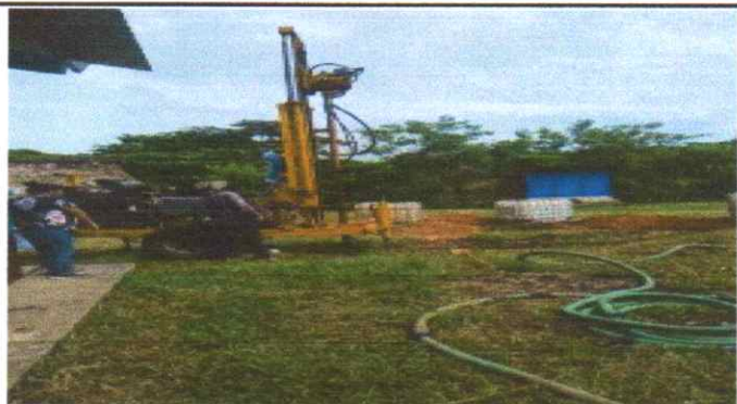
Foto 1: DURANTE LA PERFORACION DEL POZO MECANICO
