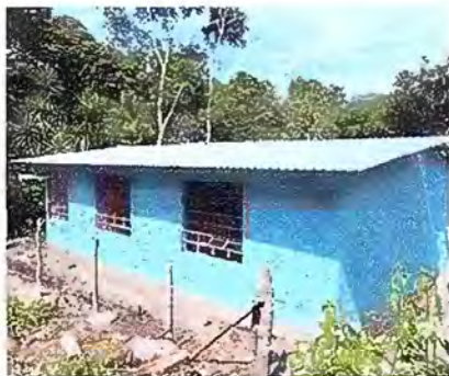
Foto1: Sustitución de lamina troquelada
