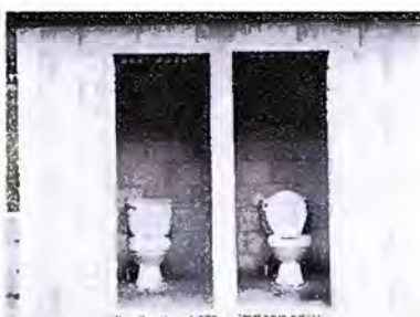
Foto 5: Sustitución de inodoros
