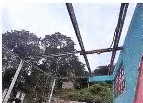
Foto 3: Sustitución de estructura de metal por metal
