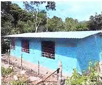
Foto1: Sustitución de lamina troquelada
