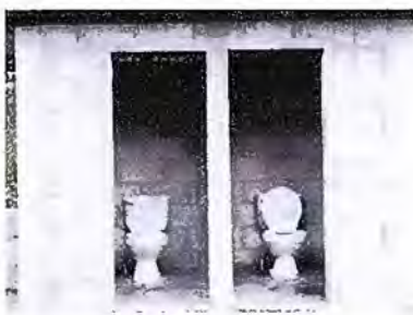
Foto 5: Sustitución de inodoros
