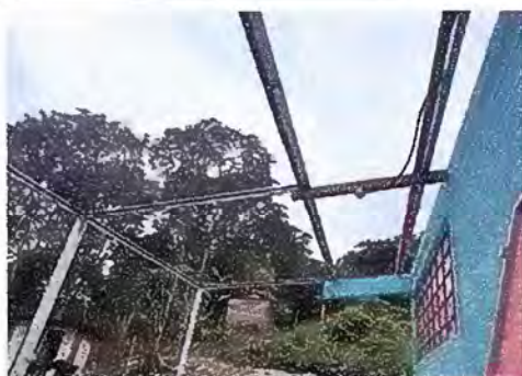
Foto 3: Sustitución de estructura de metal por metal
