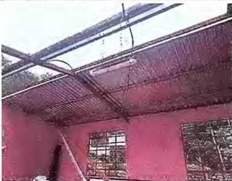
Foto 5: Sustitución de estructura de soporte de metal
