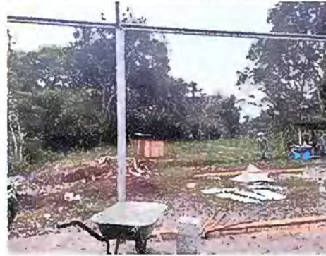
Foto 2: Reparación de estructura de metal
