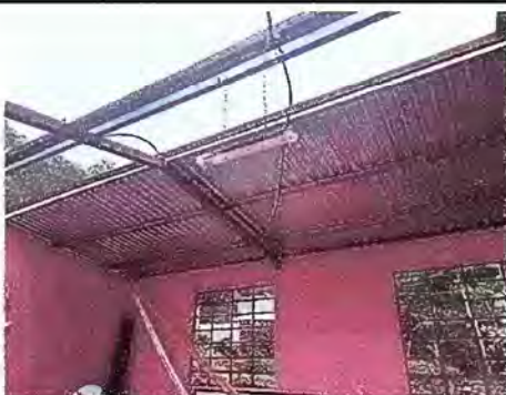
Foto 5: Sustitución de estructura de soporte de metal
