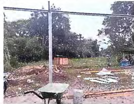
Foto 2: Reparación de estructura de metal
