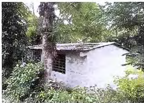
Foto 1: Modulo 1: Sustrucion de lámina, por lámina troquelada y sustitución de capote
