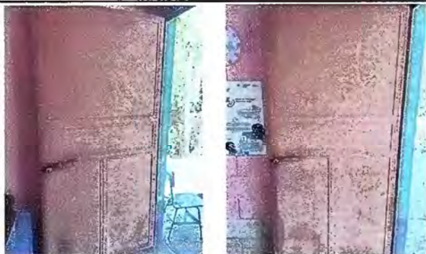
Foto 3: Modulo 1: Mantenimiento a estructura de puerta
