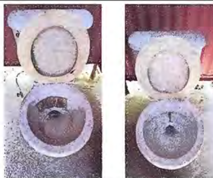
Foto 6 Modulo 2: Sustrución de inodores
