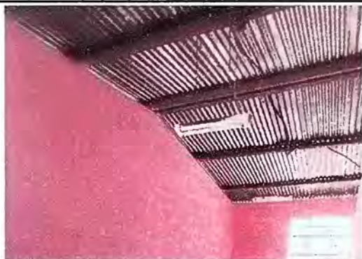
Foto 9: Modulo 1: Instalación de unidades de luz
