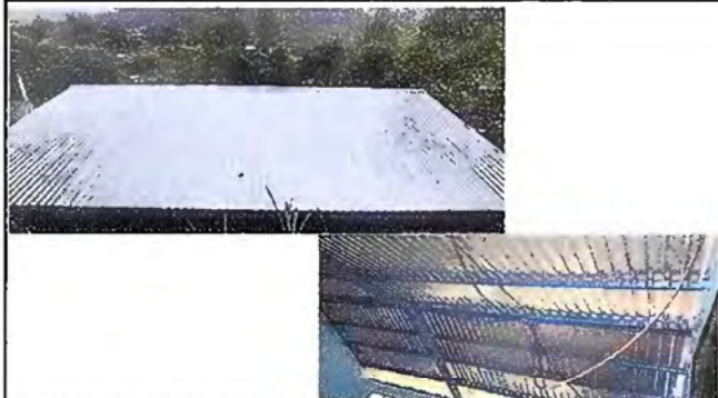
Foto 1: modulos 1: sustitución de lamina y mantenimiento de estructura de metal.
