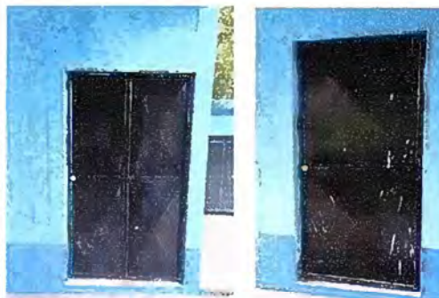
Foto 2: Modulo 1: Sustitución de Chapa, mantenimiento de estructura de puerta
