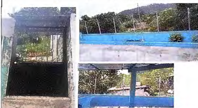
Foto 3: Modulo 1: Mantenimiento de porton de metal, reparación de muro perimetral de block con tubo de HG, Maya y solera intermedia.
