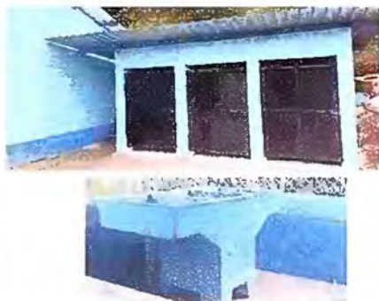
Foto 5: Modulo 2: Sustitución de puertas de servicios sanitarios, sustitución de lamina y estructura de madera por metal, sustitución de pila de cemento de dos lavaderos e instalación.
