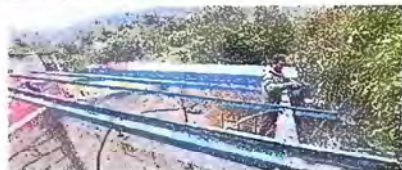
Foto 1: modulo 1: sustitución de lamina y mantenimiento de estructura de metal.
