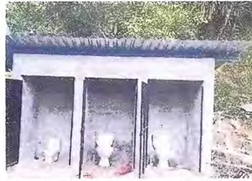
Foto 4: Modulo 2 Sustitución de inodoro e instalación.
