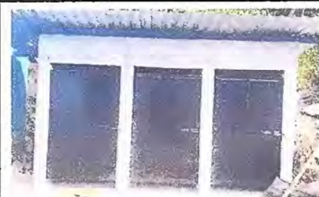
Foto 5: Modulo 2: Sustitución de puertas de servicios sanitarios, sustitución de lamina y estructura de madera por metal, sustitución de pila de cemento de dos lavaderos e instalación.
