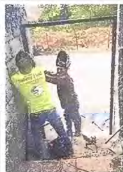
Foto 3: Modulo 1: Mantenimiento de porton de metal, reparación de muro perimetral de block con tubo de HG, Maya y solera intermedia.
