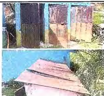
FOTO 5. MODULO 2: Sustitucion de puertas en servicios sanitarios, sustitucion de lamina y estructura de madera por metal, Sustitucion de pila de cemento de dos lavaderos e instalacion.
