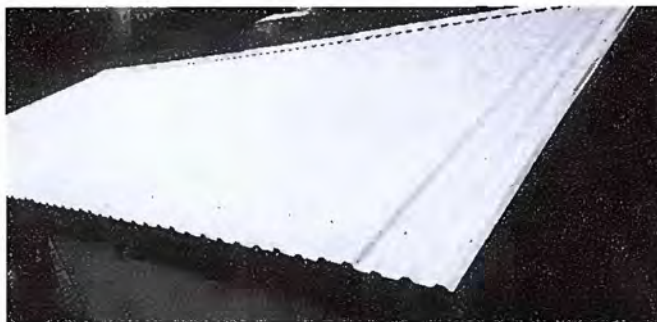
Foto 2: SUSTITUCIÓN DE CAPOTE
