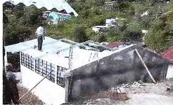
Foto 2: SUSTITUCIÓN DE ESTRUCTURA DE METAL
