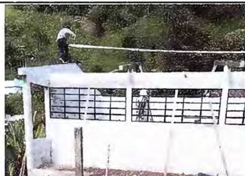
Foto 3: COLOCACIÓN DE COSTANERAS
