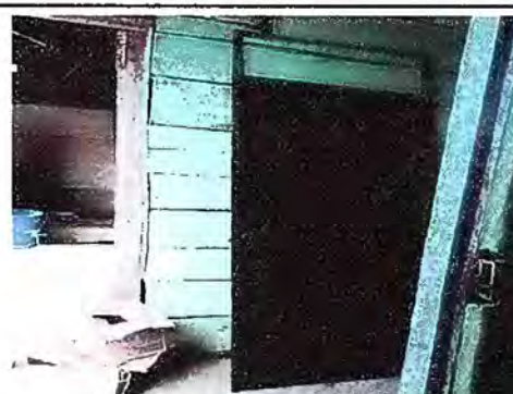
Foto 4: SUSTITUCIÓN DE PUERTA DE METAL
