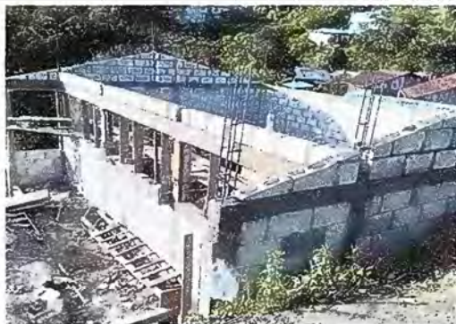
Foto1: REPARACIÓN DE PARED
