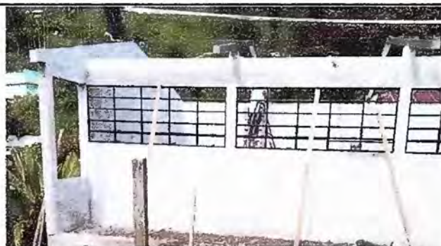
Foto 5: COLOCACIÓN DE VENTANAS DE ESTRUCTURA DE METAL
