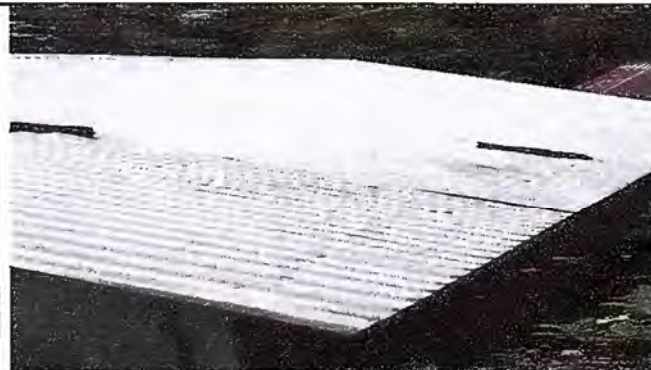
Foto 4: SUSTITUCIÓN DE LÁMINA POR LÁMINA TROQUELADA ALUZINC 26
