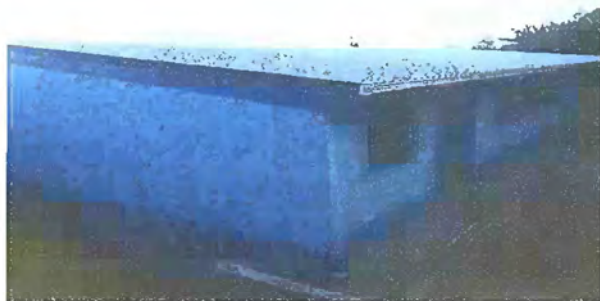
Foto1: Modulo 1 Sustitución de lámina del techo. Finalizado
