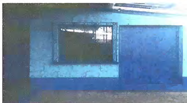
Foto 4 Modulo 1 Sustitucion de vidrios. Finalizado
