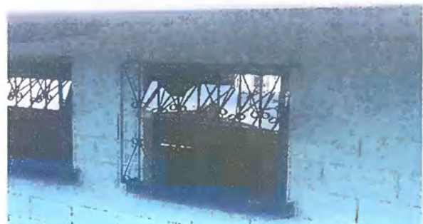
Foto 5: colocación de balcones. Finalizado
