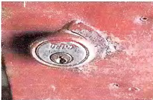
Foto 3: Modulo 1 Sustitución de chapa
