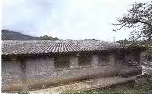
Foto1: Modulo 1 Sustitución de lámina del techo.
