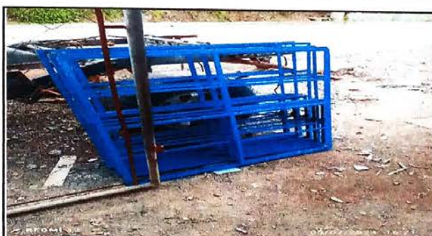
Foto 6: Preparacion de ventanas
