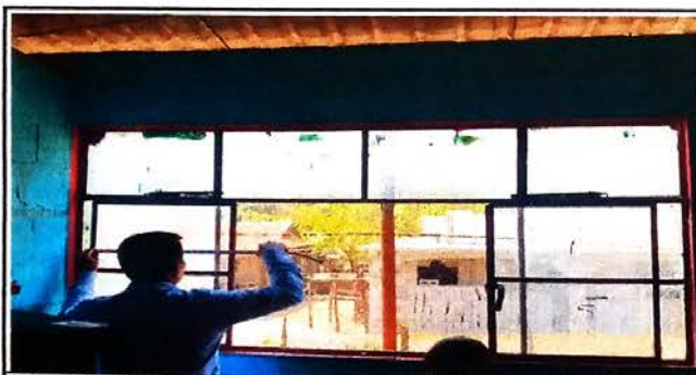
Foto 5: Medida y sustitucion de vidrios
