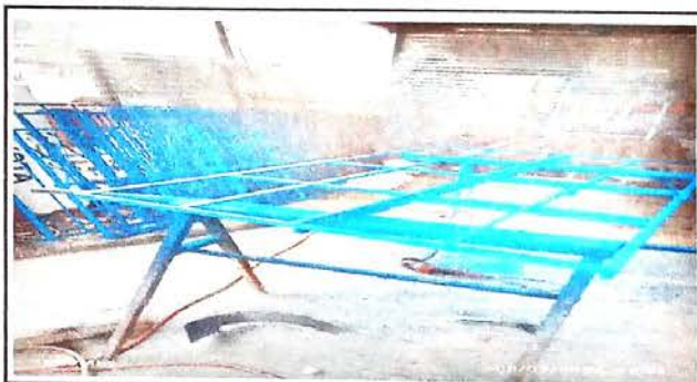
Foto 4: Preparacion de balcones
