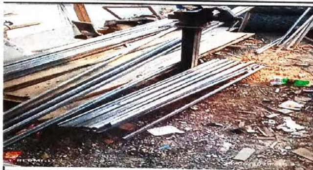
Foto 1: Preparacion de tubo
