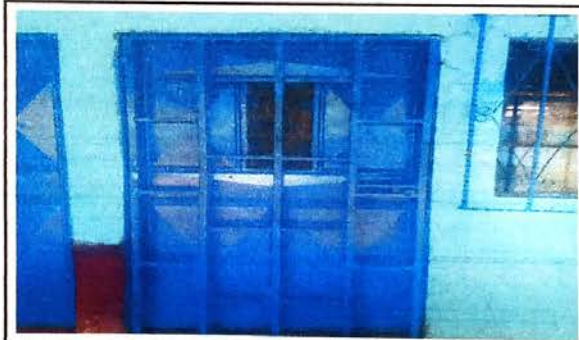
Foto 4: Proceso de mantenimiento de puertas
