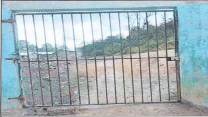
Foto1: Reparación y mantenimiento del portón
