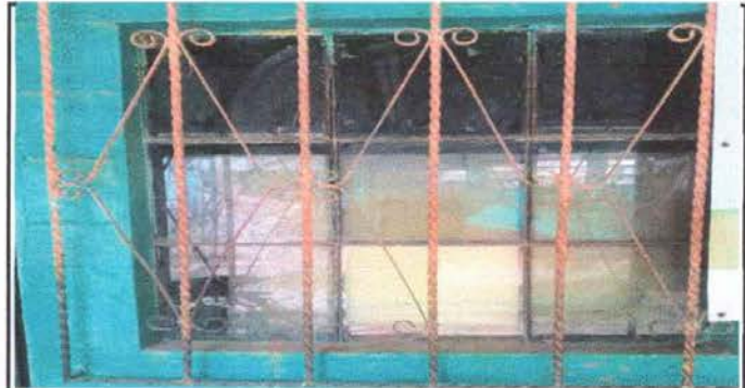
Foto 2: sustitucion de balcon.
