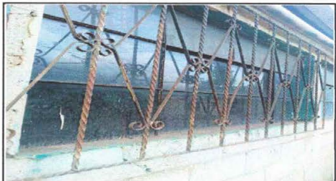
Foto 4: sustitucion de balcon.
