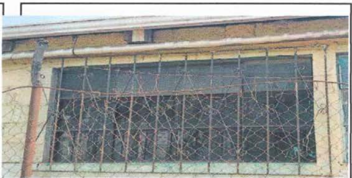
Foto 6: sustitucion de balcon.
