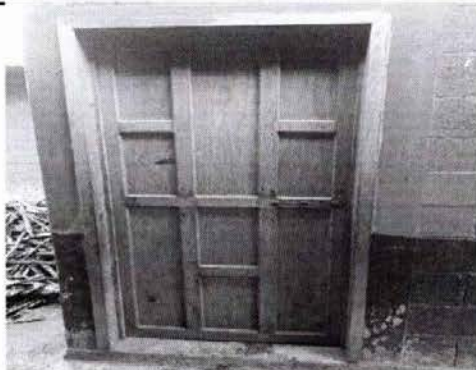
Foto1: Sustrucción de puerta de madera por metal.
