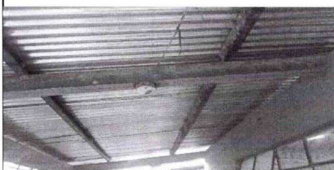
Foto 4: Sustrucción de focos ahorradores.
