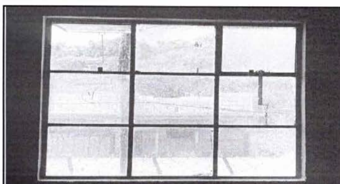
Foto 4: Sustitucion de vidrios e instalacion de balcon
