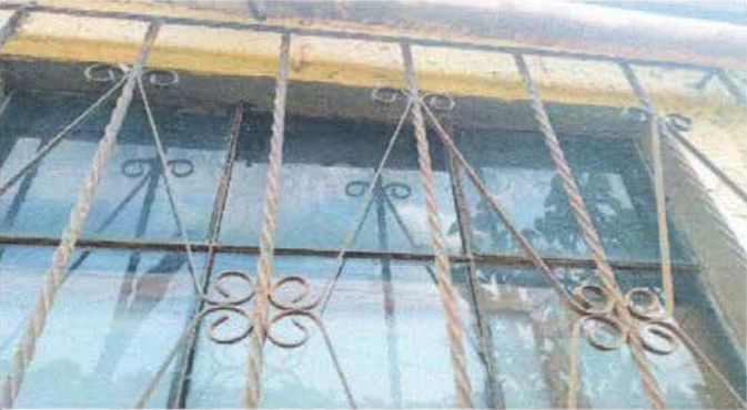
Foto 3: sustitucion de balcon.
