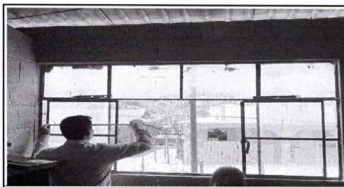
Foto 5: Sustitucion de vidrios e instalacion de balcon
