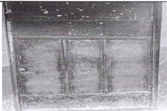
Foto 2: Mantenimiento de puertas.
