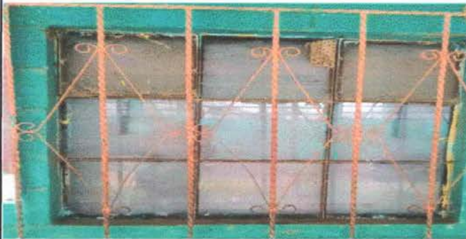
Foto 1: sustitucion de balcon
