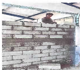
Foto 2: Reparación y construcción de Pared en aulas
