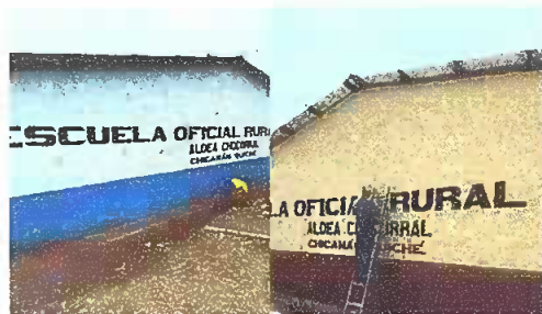
Foto 5: Sustitución de pintura de centro educativo.
