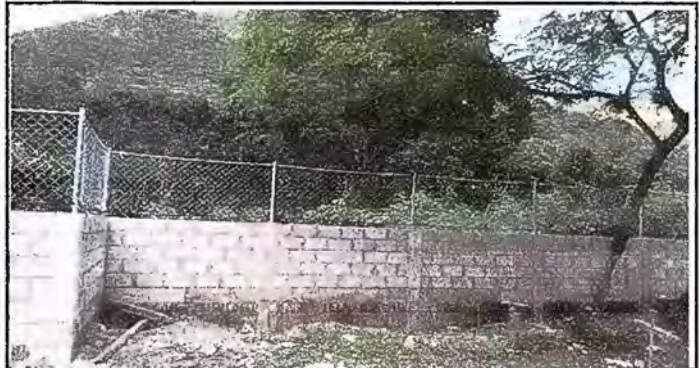
Foto 6 Reparación de muro perimetral de block con tubo hg , soleras intermedias y columnas
