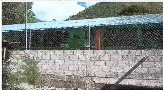
Foto 3 Reparación de muro perimetral de block con tubo hg , soleras intermedias y columnas
