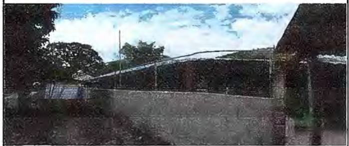
Foto 4 Reparación de muro perimetral de block con tubo hg , soleras intermedias y columnas
