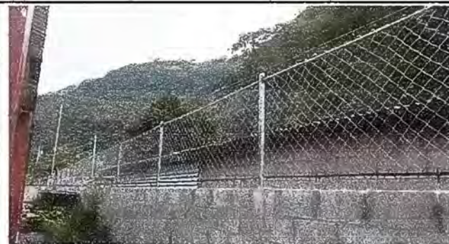
Foto 5 Reparación de muro perimetral de block con tubo hg , soleras intermedias y columnas
