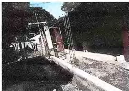
Foto 3 Reparación de muro perimetral de block con tubo hg, soleras intermedias y columnas
