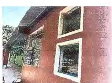
Foto 3 Módulo 1: Suministro e instalación de balcon de metal en ventanas
