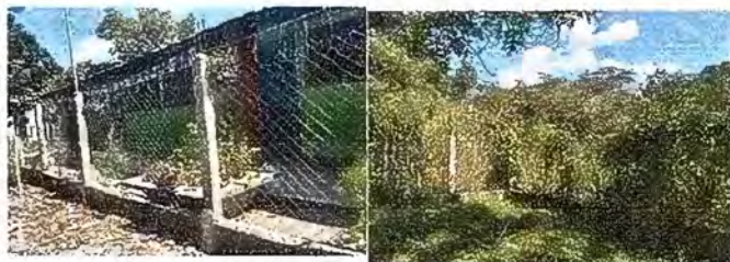
Foto 6 Reparación de muro perimetral de block con tubo hg y malla galvanizada, soleras intermedias y columnas
