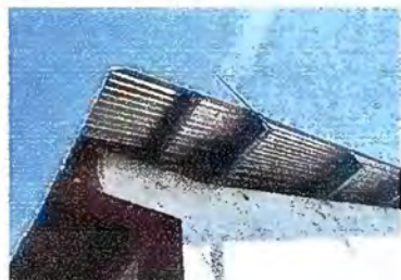
Foto 1 Módulo 1: Sustitución de lámina por lámina troquelada en la parte de la dirección
