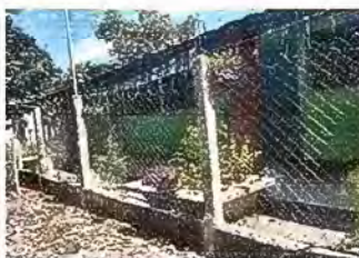
Foto 6 Reparación de muro perimetral de block con tubo hg y malla galvanizada, soleras intermedias y columnas
