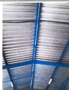
Foto 2: Sustrucción de láminas calibre 26
