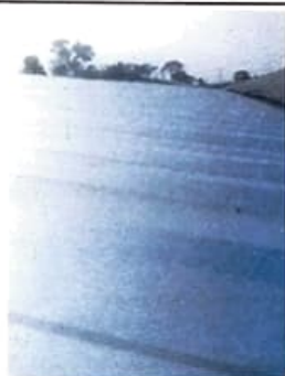
Foto 3: Sustrucción de techo calibre 26
