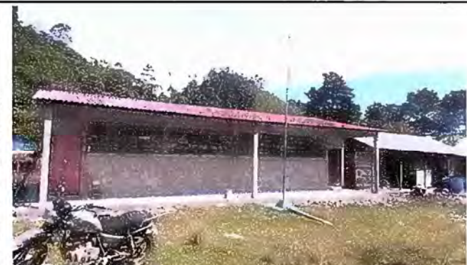
Foto 4: MODULO 1 pintura de muros interior y exterior
