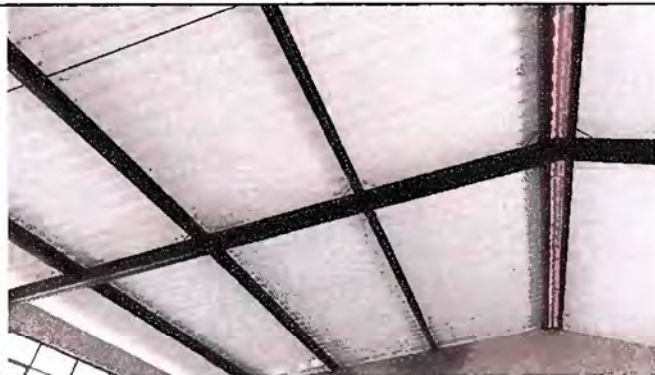
Foto 1: MODULO 1 Sustitucion de lámina, Por Lamina Troquelada aluzinc calibre 26
