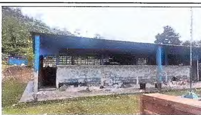
Foto 4: MODULO 1 pintura de muros interior y exterior
