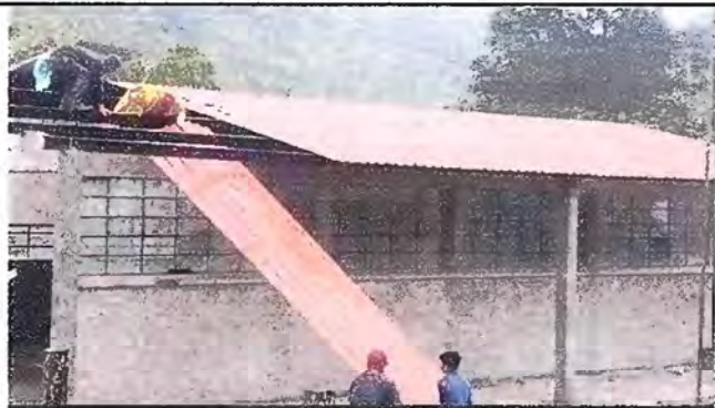
Foto 1: MODULO 1 Sustitución de lámina, Por Lamina Troquelada aluzinc calibre 26
