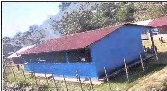
Foto 4: MODULO 1 pintura de muros interior y exterior
