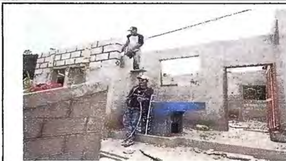
Foto 2. Modulo 3: sustitución de lámina por lámina troquelada
