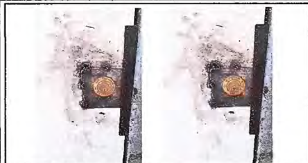
Foto 1. Modulo 1 y 2: sustitución de chapas
