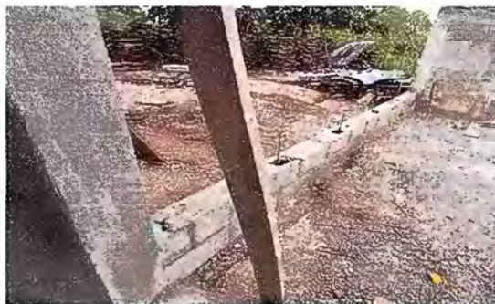
Foto 11. áreas exteriores: Reparacion en block (incluye columnas)
