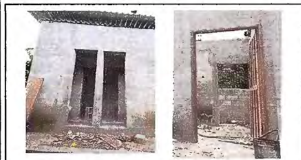
Foto 3. Modulo 3: suministros e sustitución de puerta de metal
