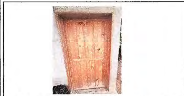
Foto 3. Módulo 3: suministros e sustitución de puerta de metal
