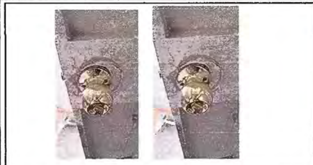
Foto1. Módulo 1 y 2: sustitución de chapas
