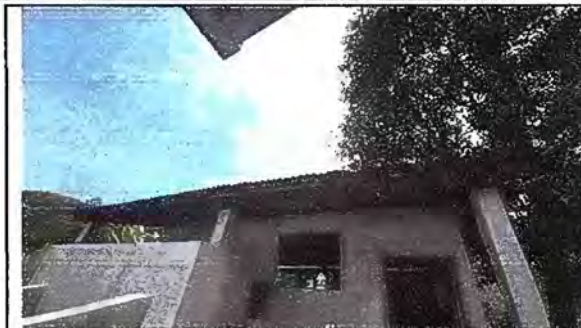
Foto 2. Módulo 3: sustitución de lámina por lámina troquelada
