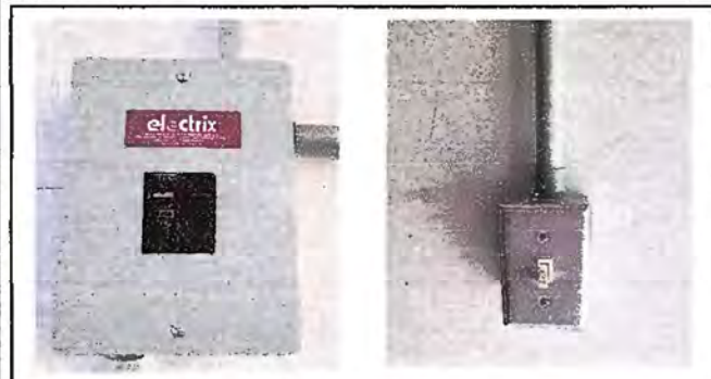
Foto 7. Modulo 3: sustitución interruptores dobles
