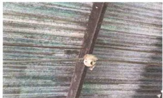
Foto 4: SUSTITUCIÓN DE LÁMPARAS TIPO LED
