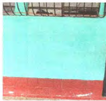
Foto 10: PINTURA EN MUROS EXTERIORES E INTERIORES
