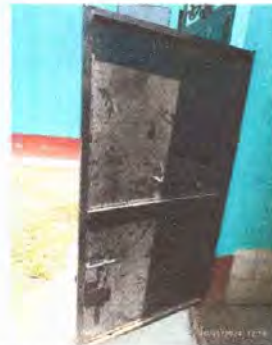
Foto 16: SUSTITUCIÓN DE PUERTAS DE METAL
