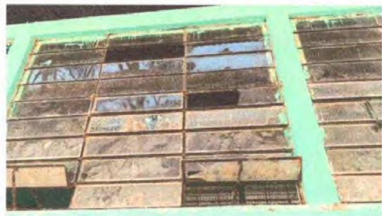
Foto 12: SUSTITUCIÓN DE VIDRIOS
