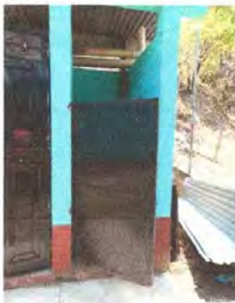
Foto 15: SUSTITUCIÓN DE PUERTAS DE METAL
