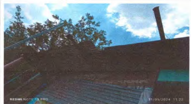
Foto 2: SUSTITUCIÓN DE LÁMINA, POR LÁMINA TROQUELADA.
