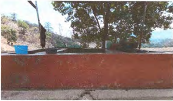
Foto 7: SUSTITUCIÓN DE PILA
