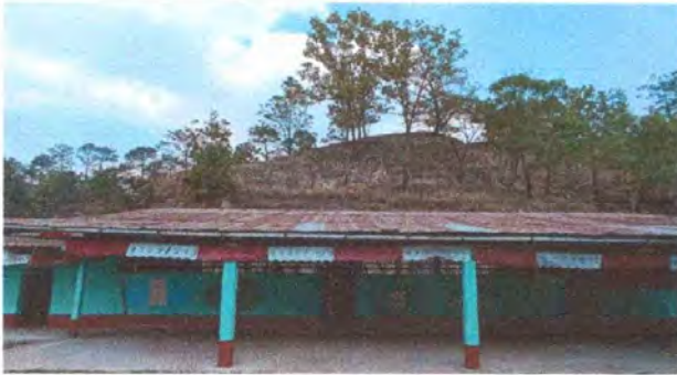
Foto 1: SUSTITUCIÓN DE LÁMINA, POR LÁMINA TROQUELADA.
