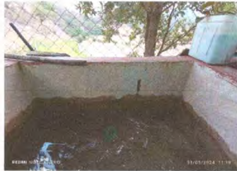
Foto 8: SUSTITUCIÓN DE PILA
