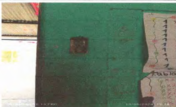
Foto 5: REPARACIÓN DE CABLEADO ELÉCTRICO
