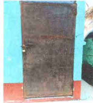
Foto 14: SUSTITUCIÓN DE PUERTAS DE METAL
