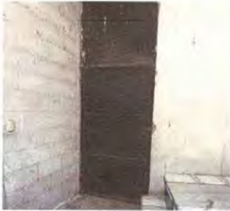
Foto 13: SUSTITUCIÓN DE PUERTAS DE METAL
