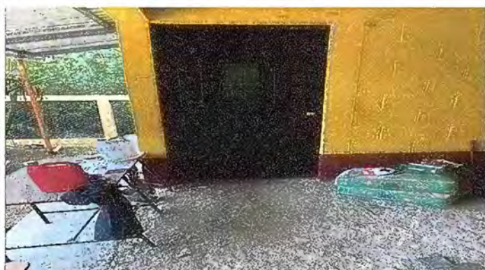
Foto 3: MÓDULO I. SUSTITUCIÓN DE PUERTA DE METAL
