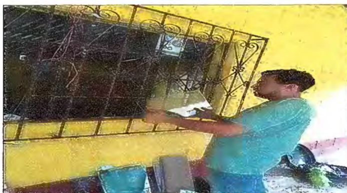
Foto 4: MÓDULO I. SUSTITUCIÓN DE VIDRIOS
