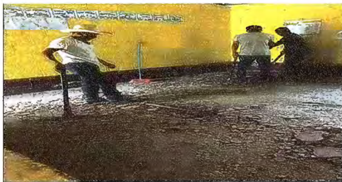
Foto 5: MÓDULO I. SUSTITUCIÓN DE PISO DE TORTA DE CONCRETO POR CERAMICO
