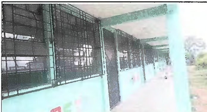
Foto 2: SUMINISTRO E INSTALACIÓN DE BALCONES DE METAL MODULO I.
