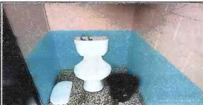
Foto 13: SUSTITUCIÓN DE ACCESORIOS DE INODORO (CONTRA LEVE, TUBO DE ABASTO Y TANQUE). MODULO IV.
