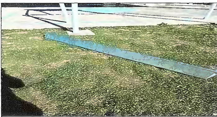
Foto 5: SUSTITUCIÓN DE CAPOTE DE LÁMINA PARA LÁMINA TROQUELADA MODULO II.
