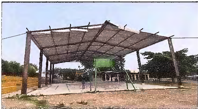
Foto 7: DESINSTALACIÓN SDE LÁMINA EXISTENTE) MODULO II.
