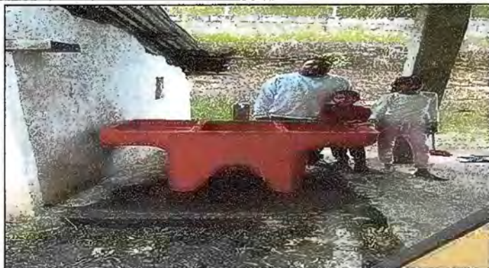
Foto 1: MÓDULO II. SUSTITUCIÓN DE PILA DE CEMENTO
