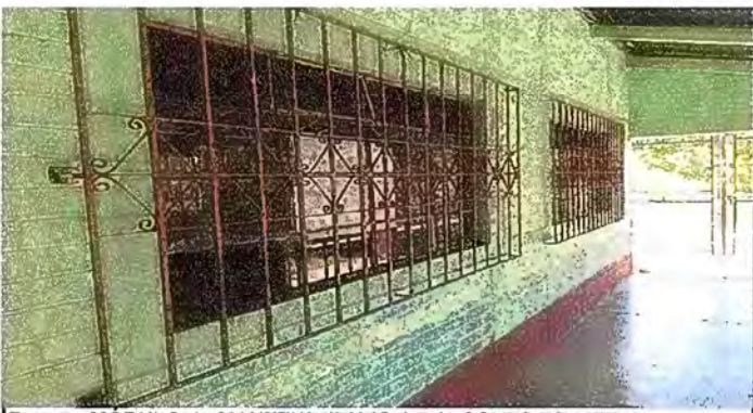
Foto 5: MÓDULO I. MANTENIMIENTO A BALCONES DE METAL
