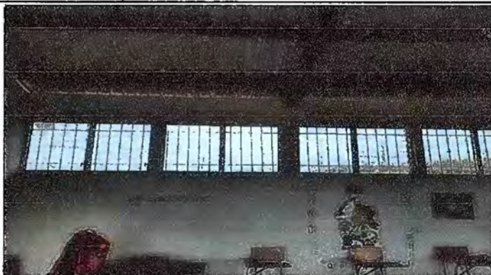
Foto 2: MÓDULO I. SUSTITUCIÓN DE VIDRIOS
