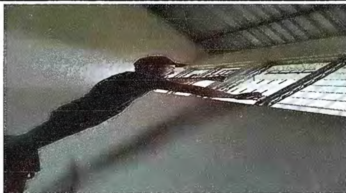
Foto 2: MÓDULO I. SUSTITUCIÓN DE VIDRIOS
