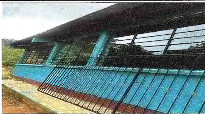
Foto 2: MÓDULO I. SUSTITUCIÓN DE VIDRIOS
