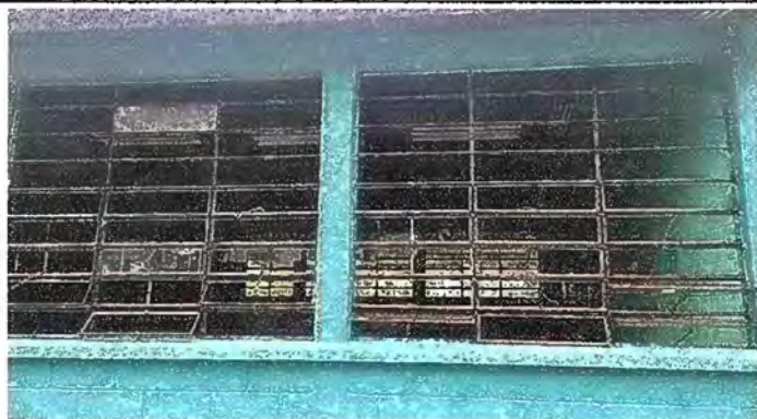
Foto 2: MÓDULO I. SUSTITUCIÓN DE VIDRIOS
